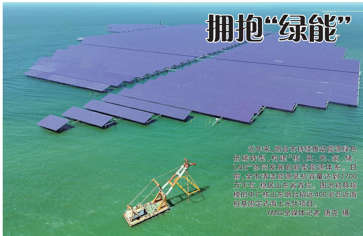
近年来，烟台市持续推动能源绿色低碳转型，构建“核、风、光、氢、储、LNG”协同发展的新型能源体系。目前，全市清洁能源装机容量达到1700万千瓦，稳居山东省首位。图为初具规模的中广核山东烟台招远400兆瓦近海桩基固定式海上光伏项目。
