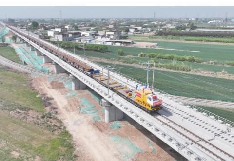
4月18日，铺轨设备在西延高铁西安阎良段进行铺轨作业（无人机照片）。当日，随着现场作业人员将首对500米长钢轨平稳地铺设在无砟轨道板上，由西成客专陕西公司建设、中铁十一局施工的西延高铁全线铺轨施工正式启动，西延高铁建设进入最后攻坚阶段。新华社
