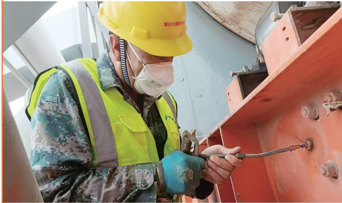
王祖永正在维修机组。
