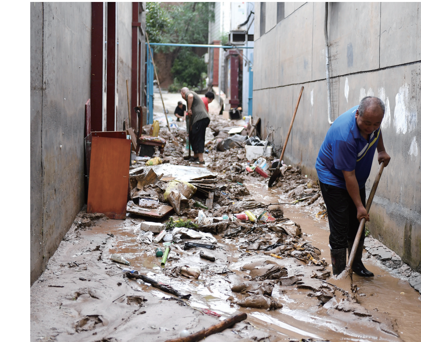
8月1日，在北京市房山区青龙湖镇上万村，村民清理山洪过后堆积的淤泥。受台风“杜苏芮”影响，北京自7月29日开始连续强降雨，西部、西南部、南部遭遇特大暴雨。受降雨影响，位于北京市房山区的部分区域发生山洪灾害，工作人员与当地村民有序清理受灾现场。 新华社
