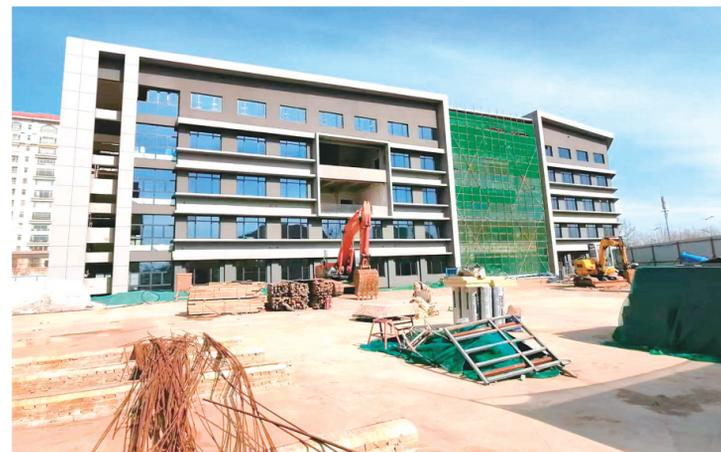
重点项目节点工作计划，定时限、定标准、定任务，建立工作台账，加快项目推进，确保项目全面提速、早见成效。截至目前，三栋建筑物主体均已完工，外立面装饰大部分完成，内部装修、管线和设备铺设正在进行中。项目预计于5月底前完工并交付使用。
